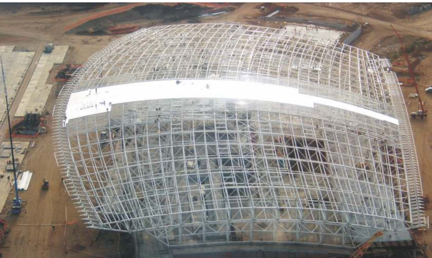
Cubierta Metálica con aislamiento. Nuevo Aeropuerto de Carrasco
