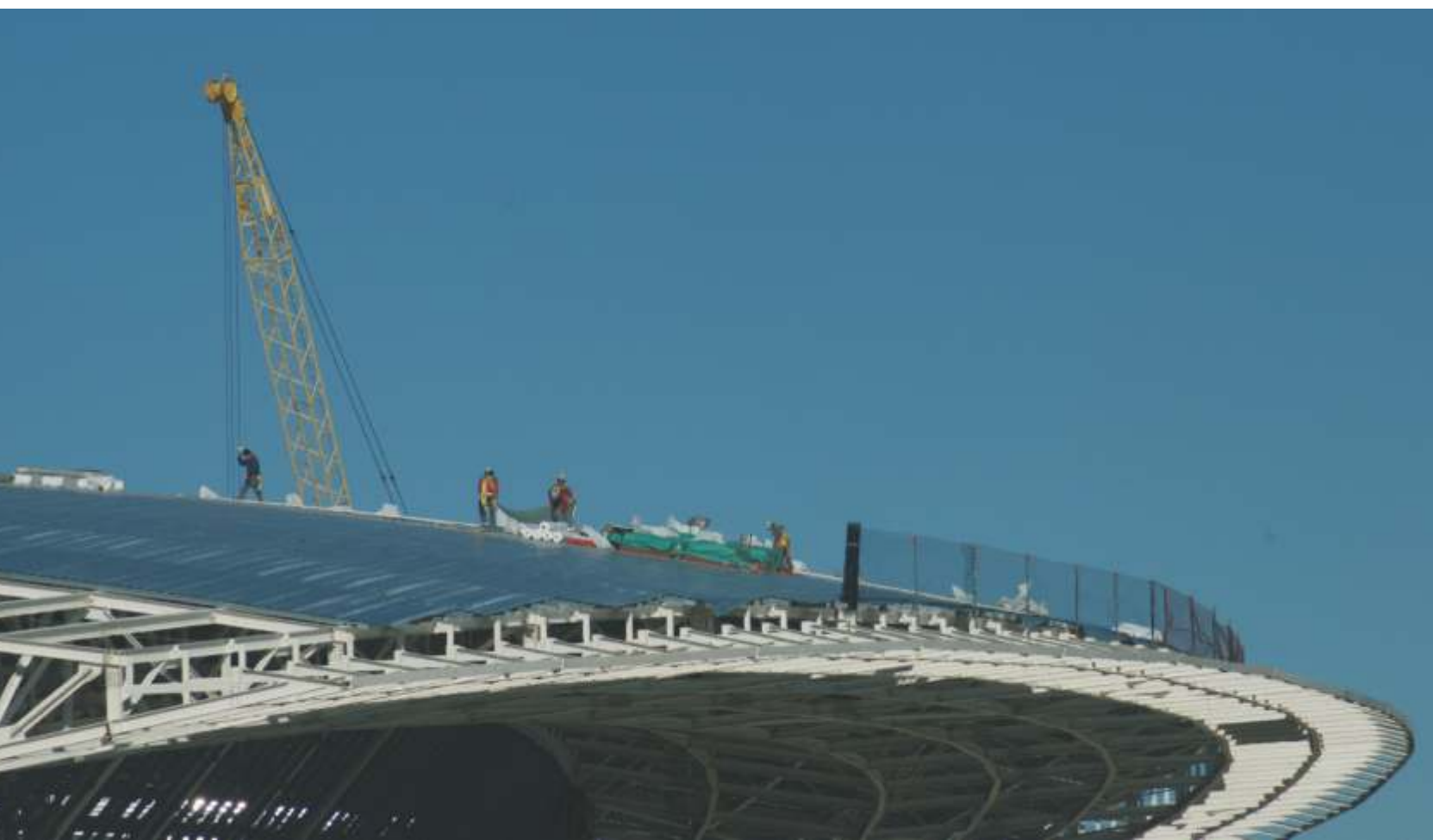
Aeropuerto Internacional de Carrasco - Cubierta con membrana TPO 46.000 m 2
