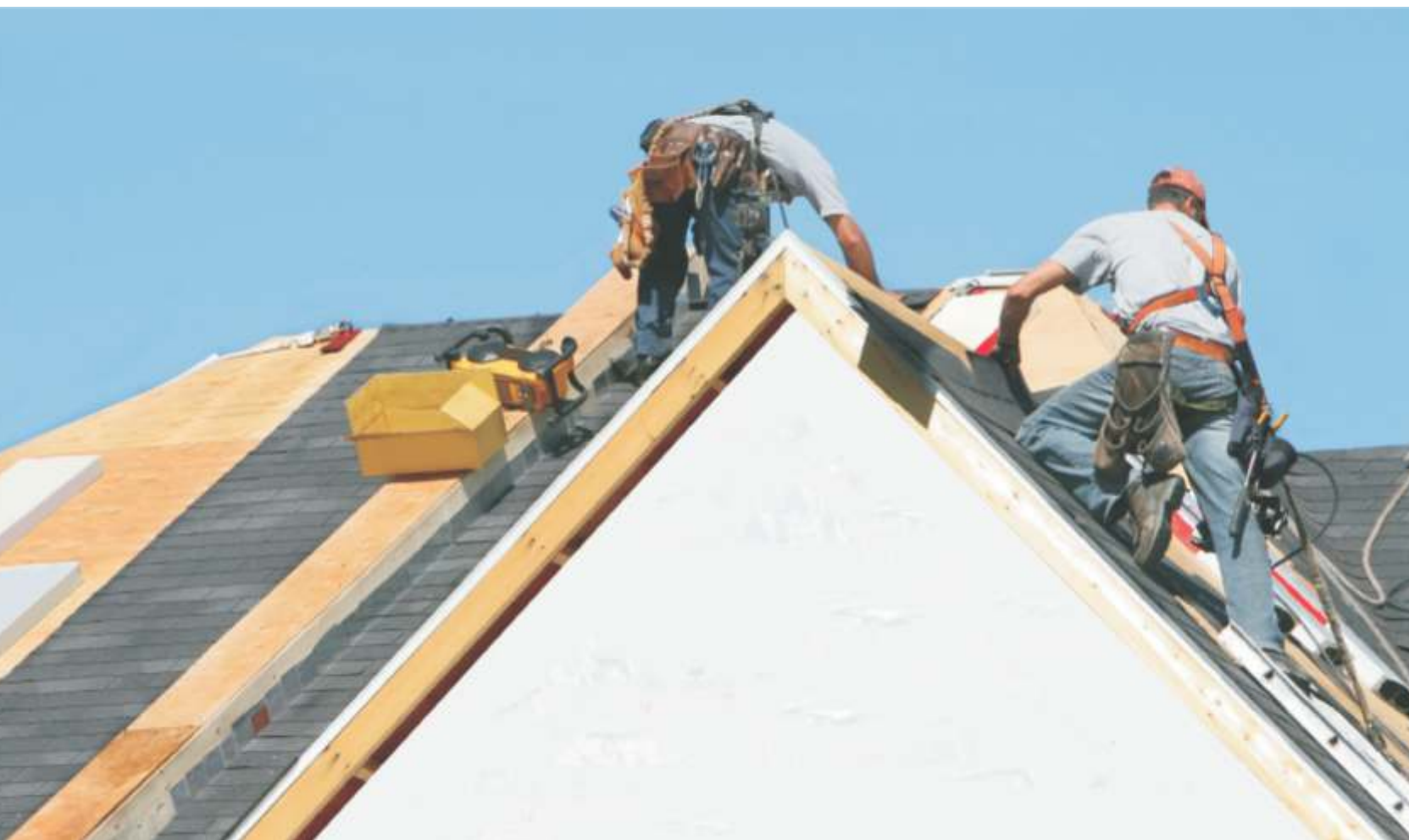
Instalacion Tejas Americanas IKO modelo plano.
